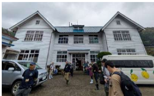
和歌山研究林庁舎の外観
