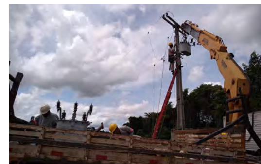
CEMGによるポールトランス（柱上変圧器）の取替え作業
