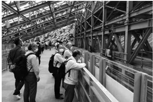
改装中の根本中堂 2F から工事の様子がわかる
